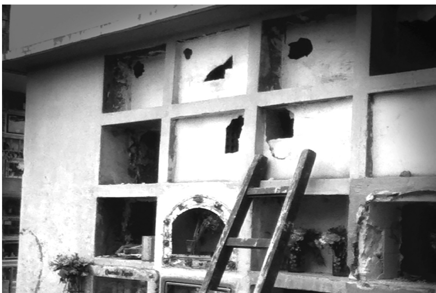
Fig. 6. Fotografía del sistema constructivo de los nichos. Fuente: Elaboración propia
