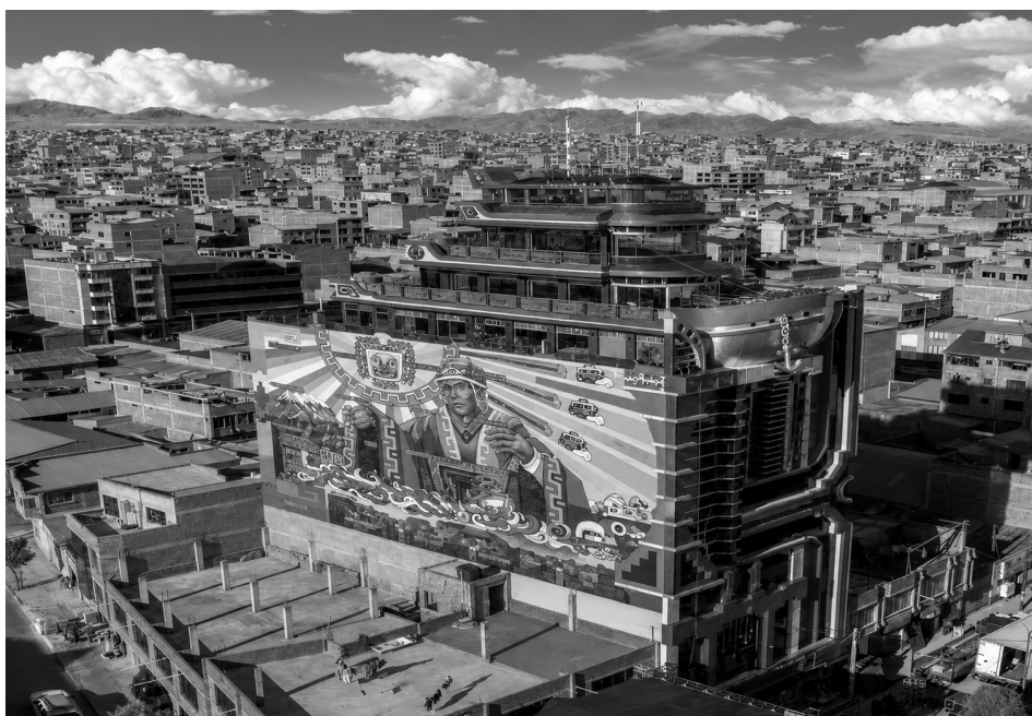
Figura 10: Edificio Crucero de los Andes en la ciudad de El Alto
