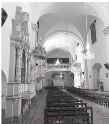
Foto 7: Vista Interior de la iglesia San Felipe Neri (Sucre), donde se aprecian los contrafuertes en pilastras. Foto propia.
