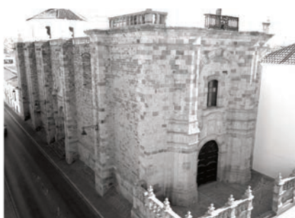
Foto 6: Vista exterior de la iglesia San Felipe Neri, donde se aprecian los contrafuertes.
