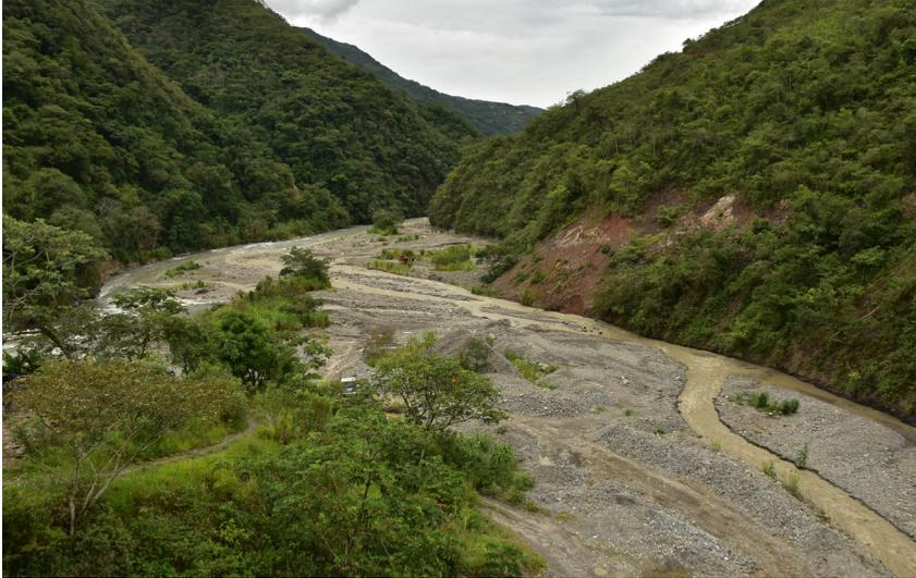
La presencia de escombros por la construcción de la carretera Cotapata-Santa Bárbara es aún notoria. Entre 1995 y 1999, solo en el río Huarinilla se lanzaron 391 millones de toneladas de escombros, excediendo en un 25% la capacidad de transporte del río. El río Yolosa presenta claras señales de una importante afectación producto de las actividades mineras río arriba.
