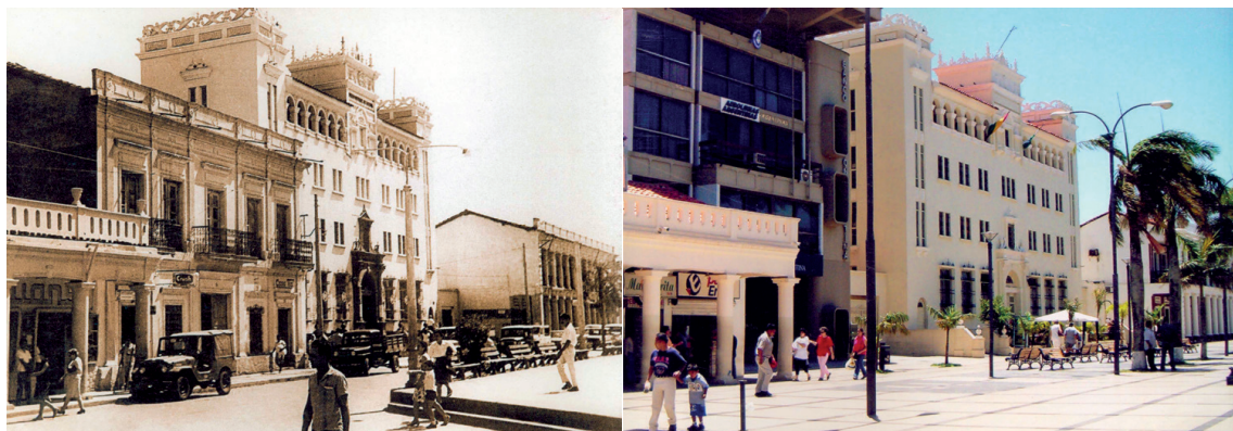
Izquierda: Vista de la acera norte de la Plaza 24 de Septiembre, Casa Salmon, Banco Central de Bolivia, Casa Zeller. Derecha: Vista de la acera norte de Plaza 24 de Septiembre, Banco de la Nación Argentina, Palacio Prefectural, Alcaldía Municipal, año 2005.
