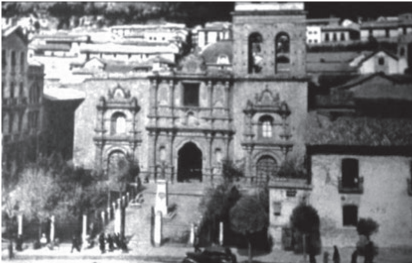
Foto en la que se observa el convento antes de la demolición Fuente: Roberto Montero, Fragments de la memoria .
