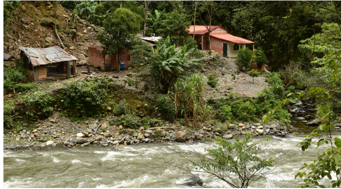
Figura 4 Mina de oro abandonada sobre el río Huarinilla, entre las comunidades de Pacallo y La Selva
