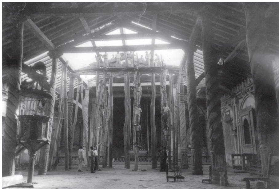
Figura 4: San Rafael, obras de refacción de una cercha quebrada con medios primitivos. Foto: Padre Agustín Harrer, 1960, Archivo Eckart Kühne, Zürich.
